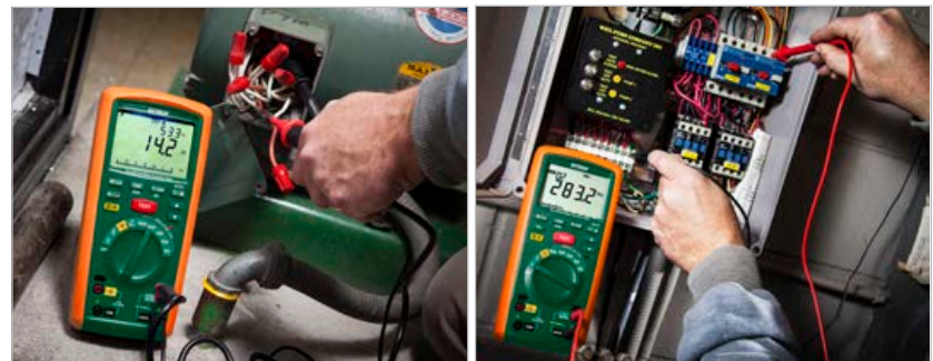
Prüfen der Spannung an einer Drehbank und Isolationprüfung an Pumpenmotor
