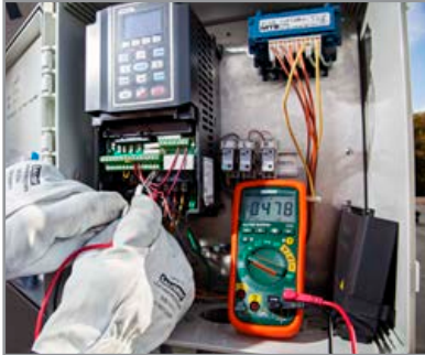
Il filtro passa basso (LPF) garantisce misure di tensione AC accurate su un VFD.
