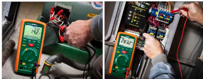
Controllo tensione su un tornio e test di isolamento sul motore di una pompa.
